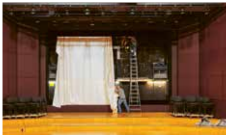
Installation du nouvel écran de la salle Paderewski
